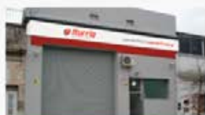
Buenos Aires Centro de Distribución Diesel
